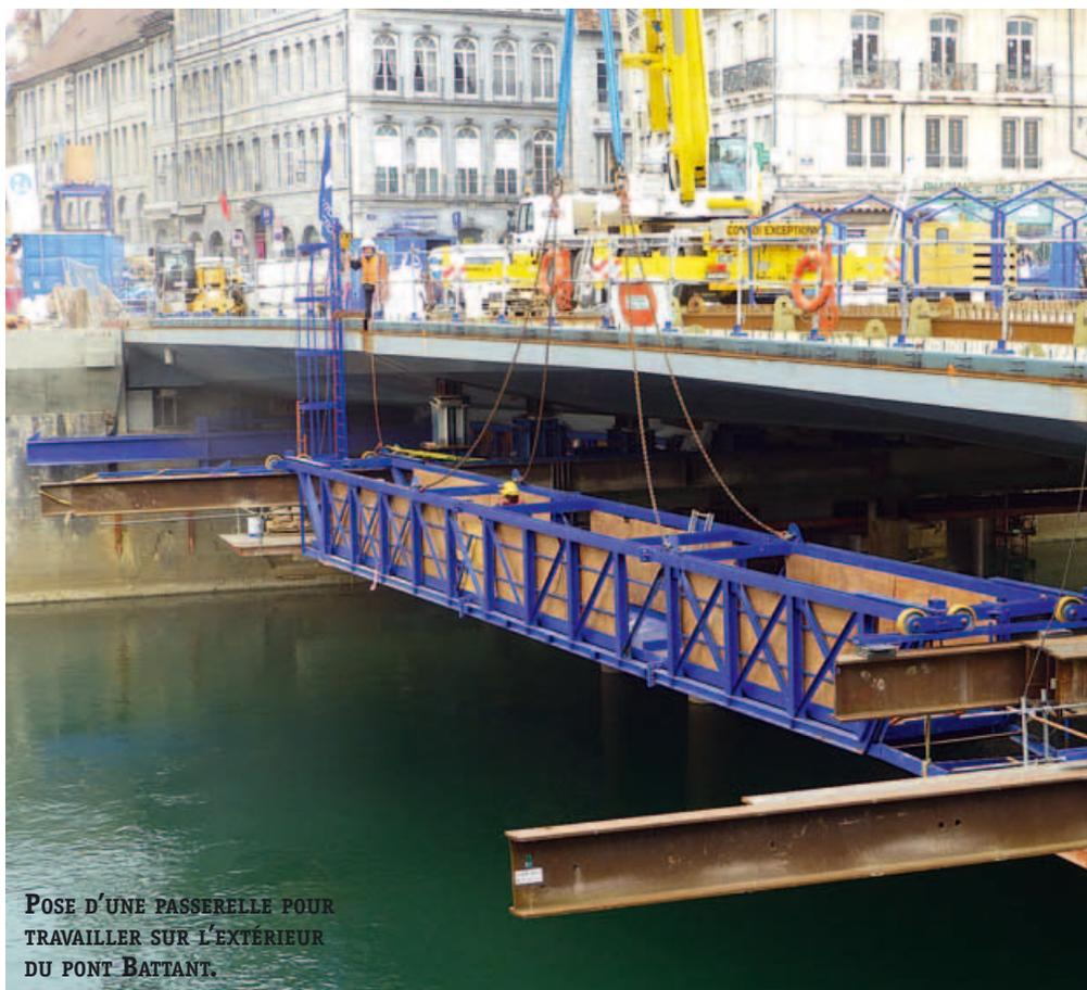
POSE D'UNE PASSERELLE POUR TRAVAILLER SUR L'EXTÉRIEUR DU PONT BATTANT.
