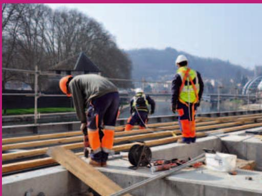
FIXATION DES MADRIERS SUR LA STRUCTURE MÉTALLIQUE DE L'ENCORBELLEMENT.
