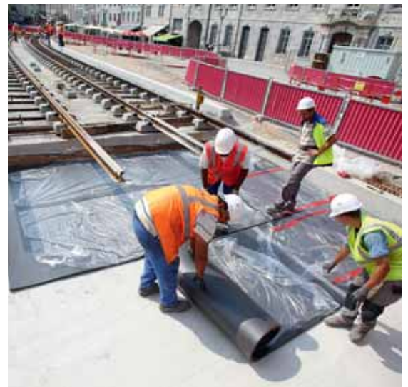
MISE EN PLACE DU TAPIS ANTI-VIBRATILE SUR LA PLACE DE LA RÉVOLUTION, LE LONG DU MUSÉE DES BEAUX-ARTS.
