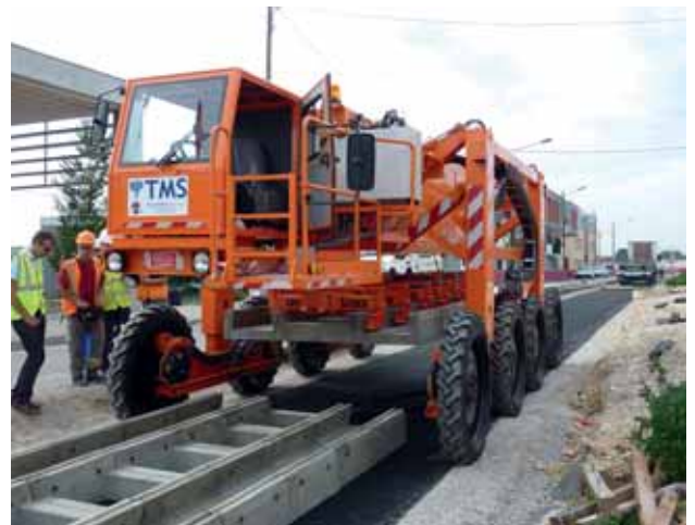
MACHINE PERMETTANT DE POSER LES AUGETS (SORTE DE BLOCS) EN BÉTON DESTINÉS À ACCUEILLIR LES RAILS.
