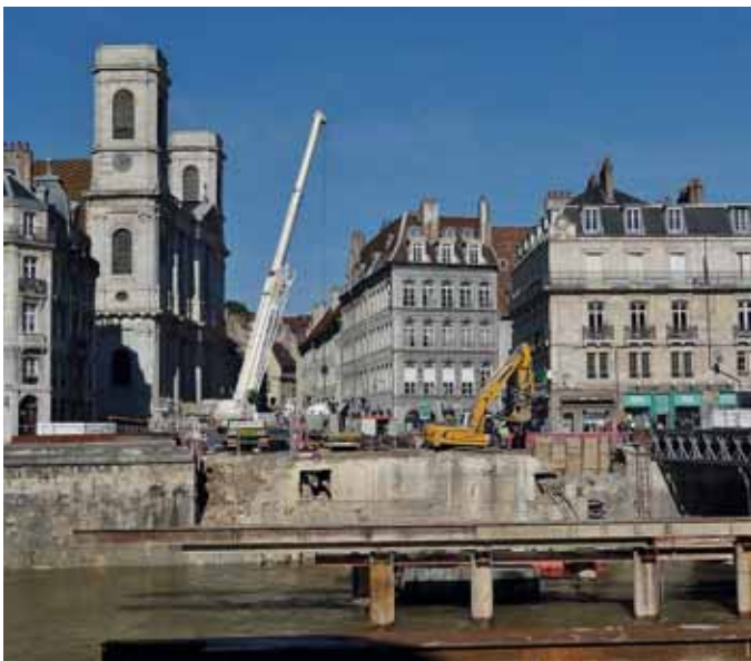
↑ LES TRAVAUX DU PONT BATTANT.
