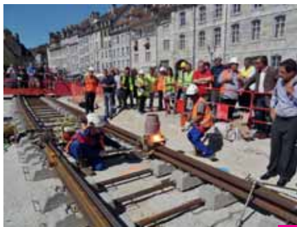
POSE DES PREMIERS RAILS, LE 8 AOÛT, PLACE DE LA RÉVOLUTION. ↑
